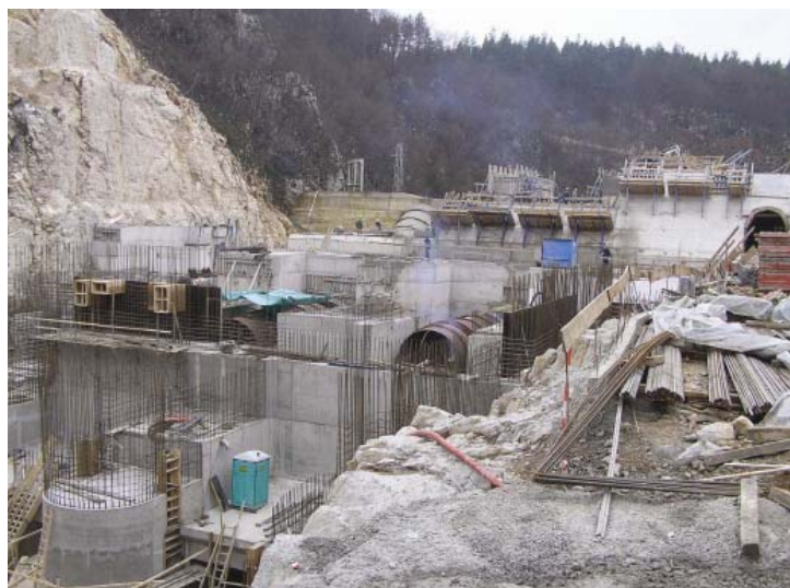
HE Lešče – izgradnja strojarnice i brane 2007
