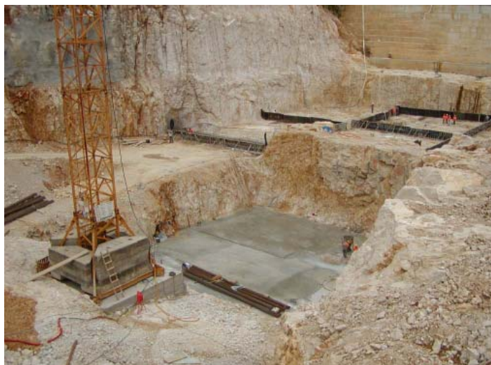
HE Lešće – priprema temelja brane u građevnoj jami
