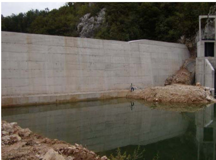
HE Lešće – dovršeni uzvodni zagat
