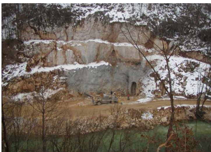
HE Lešće – izlaz iz obilaznog tunela
