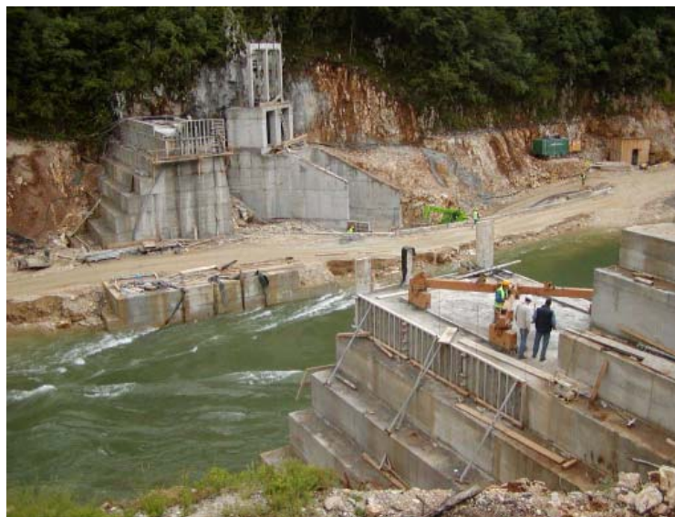
HE Lešće – ulaz u tunel i dio uzvodnog zagata
