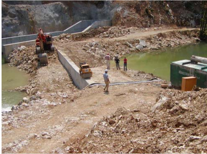
HE Lešće – izlaz iz obilaznog tunela i nizvodni zagat (privremena brana)
